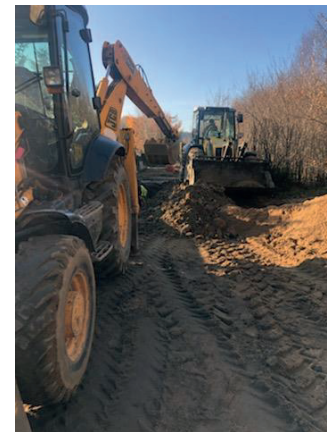
Budowa sieci kanalizacji sanitarnej w Poblocie
