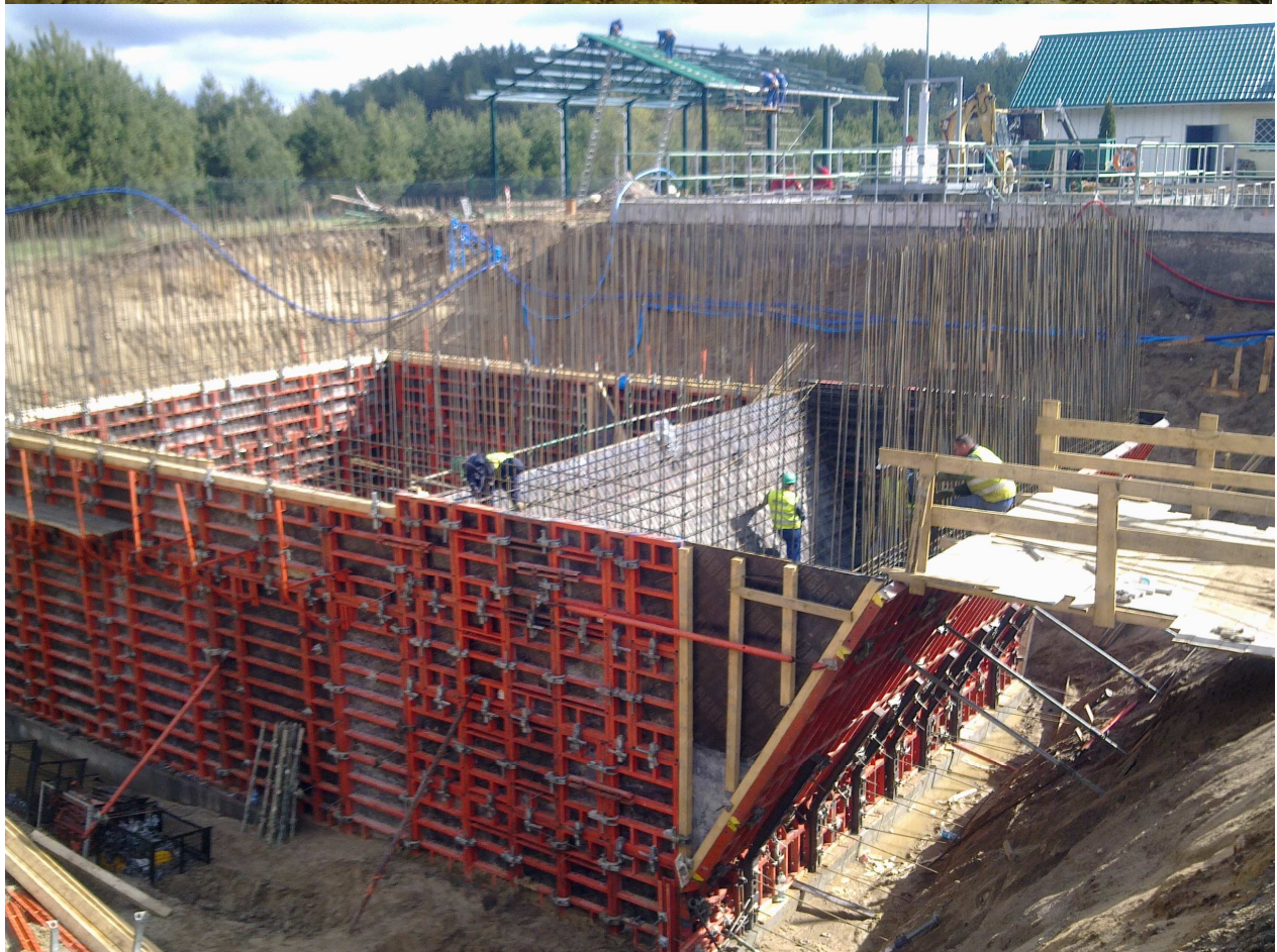
Zdjęcia: Roboty budowlane przy rozbudowie oczyszczalni ścieków w Tuczewie.
