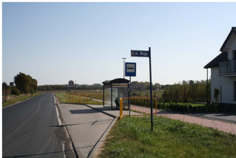
(zatoka autobusowa w Lini)
