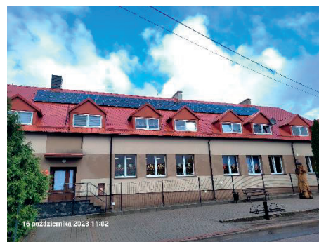
Panele fotowoltaiczne na szkole w Zakrzewie
