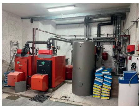
Remont kotłowni w SP Strzeczcu
